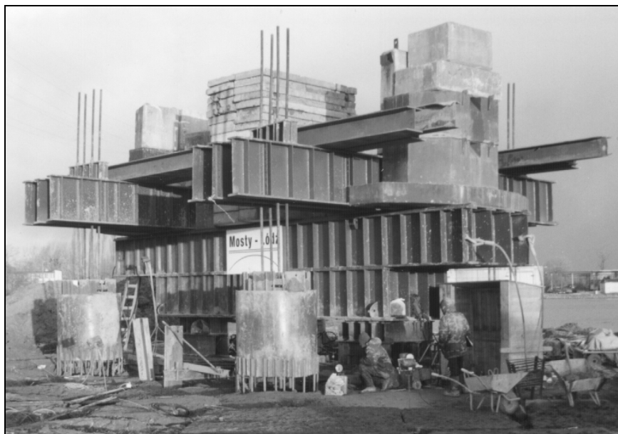
Rys. 2. Stanowisko do próbnego obciążenia pala
