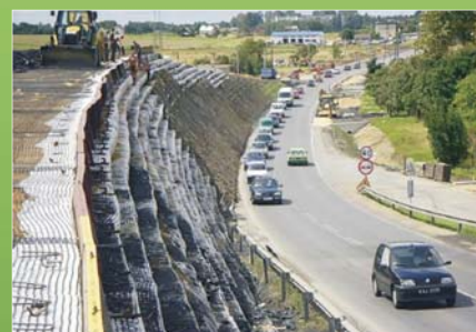
Modernizacja ul. Pszczyńskiej w Jastrzebie Zdroju.
